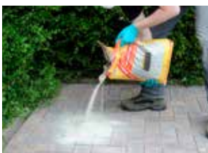
1. Pour out small amounts of Sika® FastFix-131 powder
